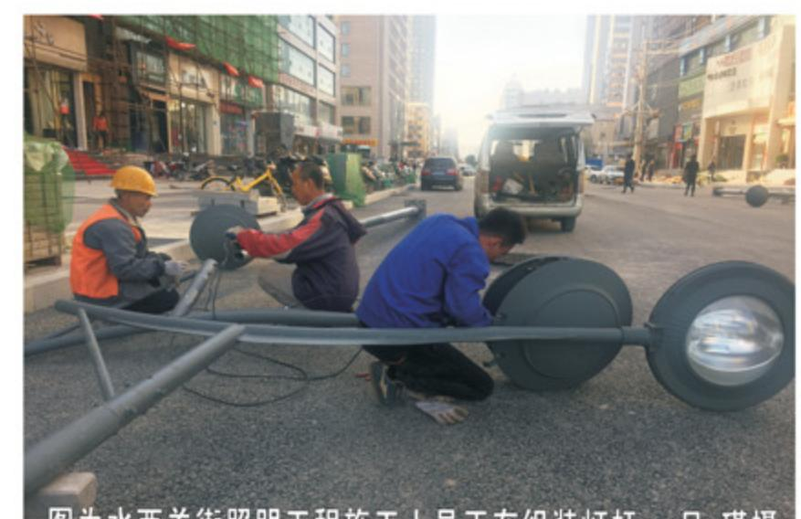
图为水西关街照明工程施工人员正在组装灯杆 吕瑾摄
